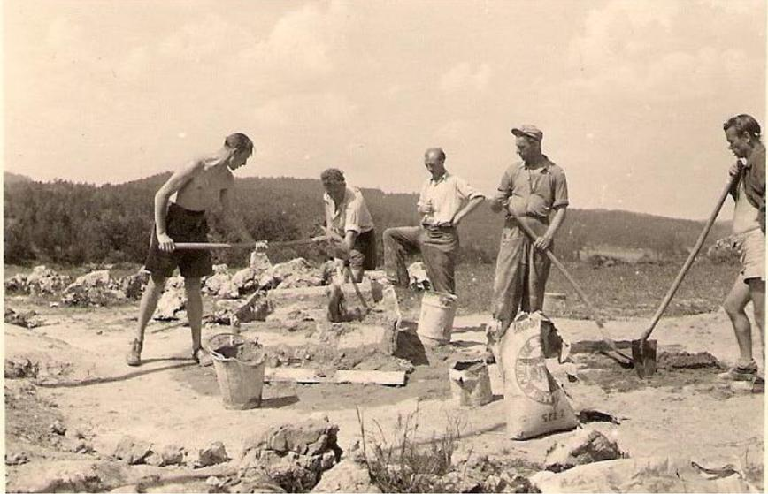
Die Grundmauern der Hütte werden nun ausgehoben und verfüllt.
